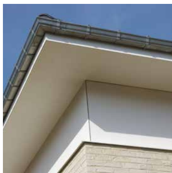
Afwerking van een dakoversteek
